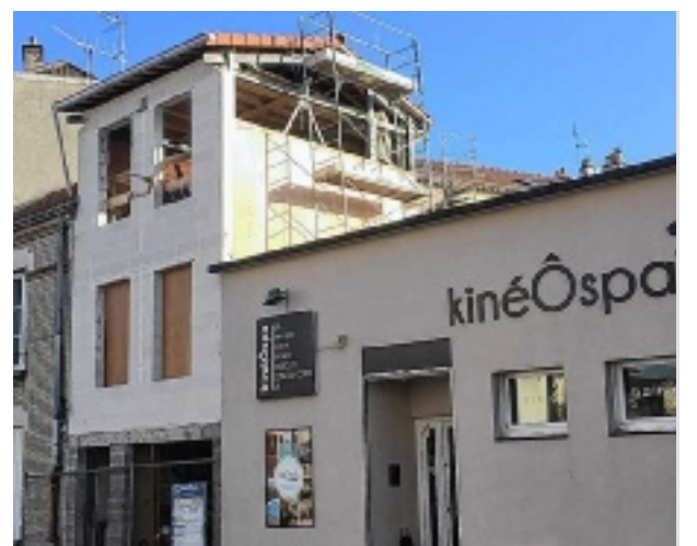
Le chantier de construction d'une habitation, rue Diderot, est arrêté depuis un an.
