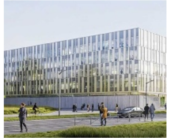
Les fonds européens financeront en partie la construction du siège de l'université de Reims-Champagne-Ardenne. Architectes Ameller & Dubois
