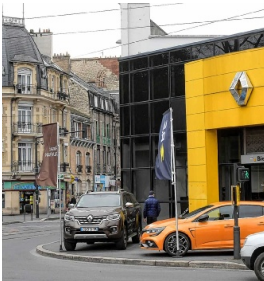
La démolition du garage Renault Pont de Vesle est prévue pour mars 2019. Christian Lantenois
