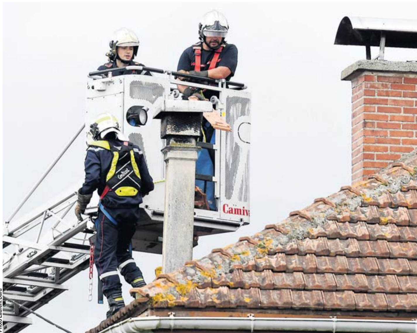
Les orages de mercredi soir ont été particulièrement forts sur le village de Goudon où plus de la moitié des toitures a été endommagée. Des inondations sont également survenues sur le Haut-Adour. page 3
