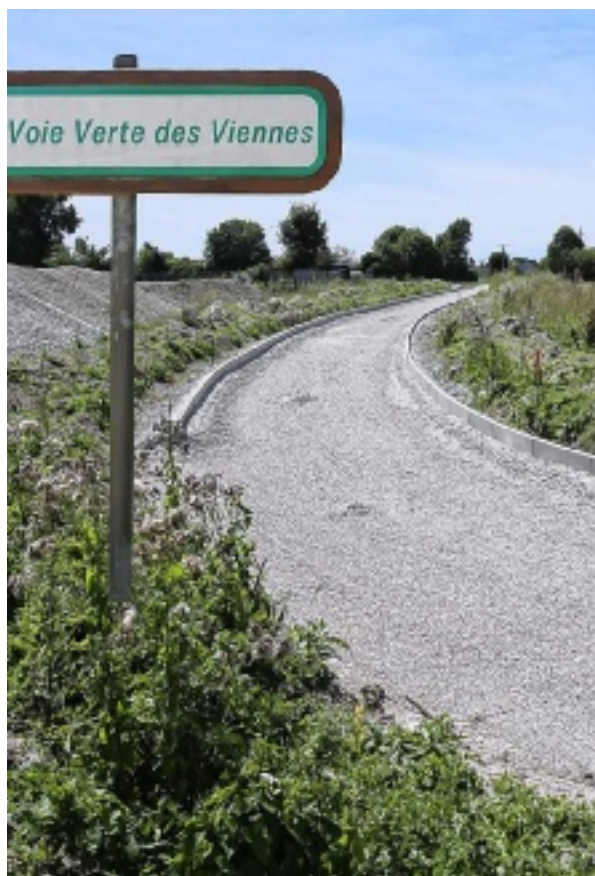
Les travaux de prolongation de la voie ont commencé.
