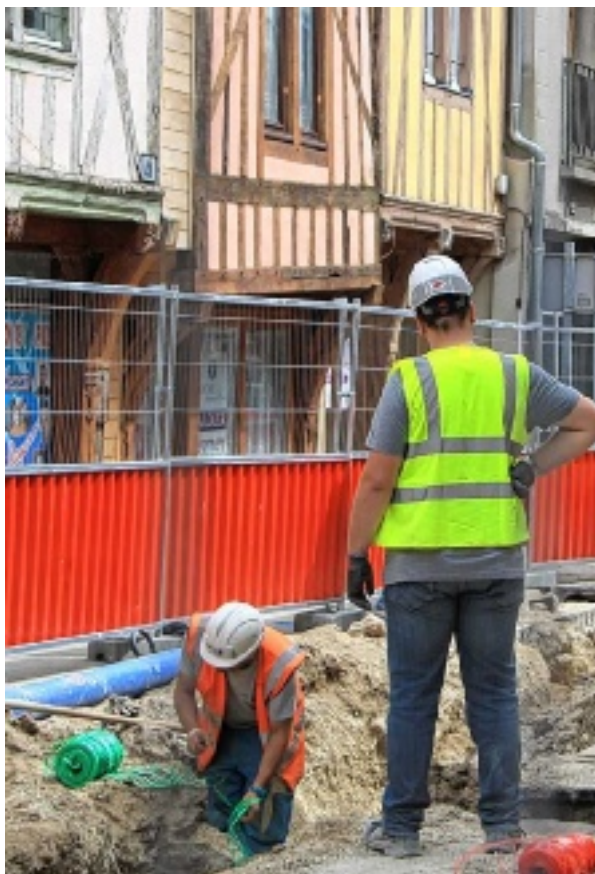
Les réseaux d'eau, de gaz et d'électricité sont en plein renouvellement.
