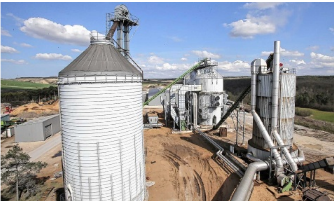
Carbonex récupère les gaz issus de la carbonisation du charbon de bois pour en faire de l'électricité verte, revendue à EDF. Photo Jérôme BRULEY
