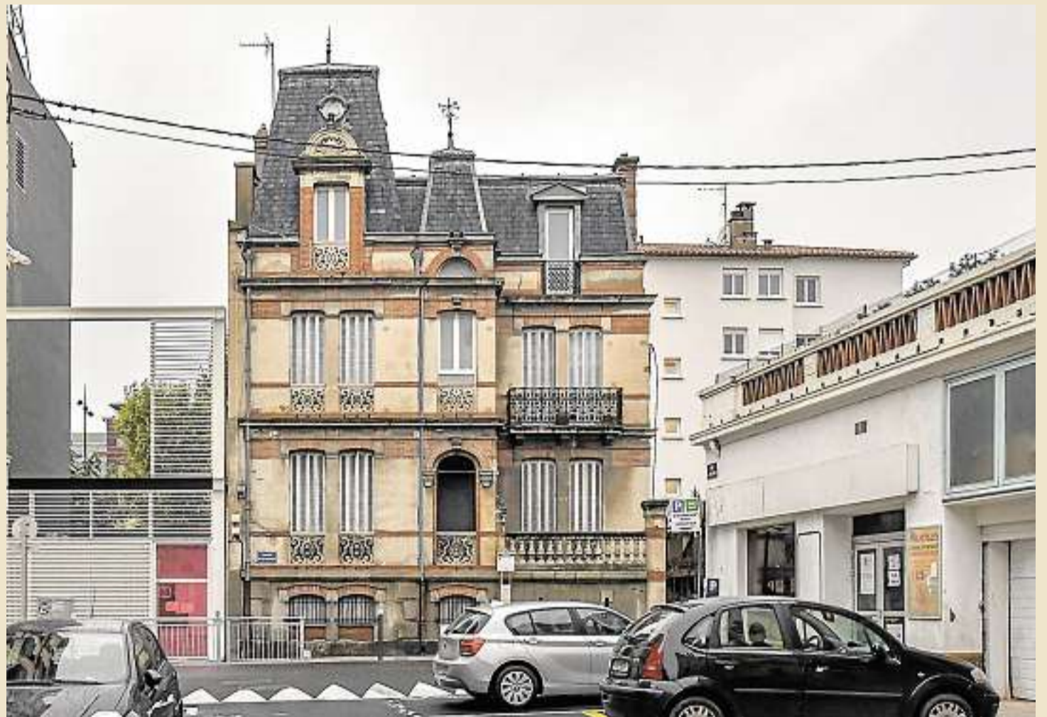
► Œuvre de l'architecte Petersen, la Maison Jacomet, située rue Courteline près de la gare, est proposée à l'euro symbolique par la Ville. Une quinzaine d'associations se sont déjà positionnées. Visite guidée. Photo Olivier Got
