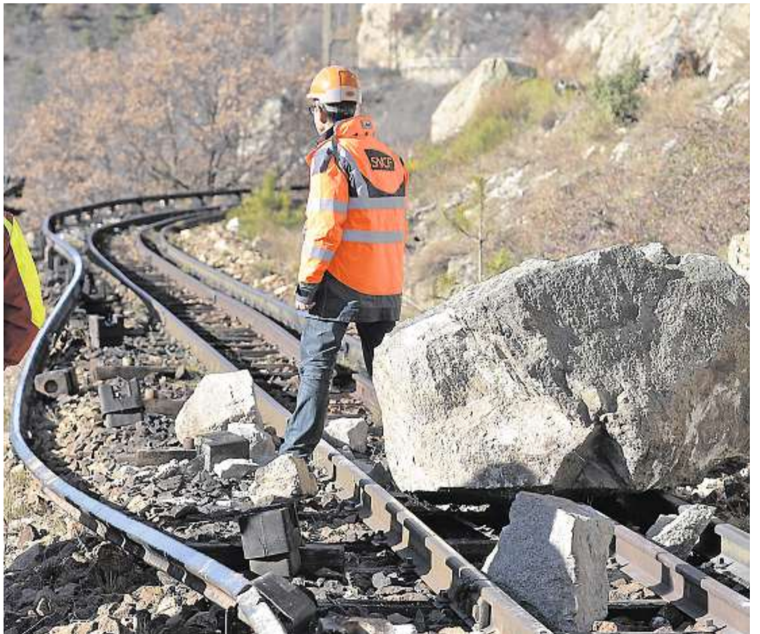
► Si la RN 116 pourrait être débloquée en fin de journée après intervention des artificiers, les travaux seront bien plus importants pour remettre en circulation le Train jaune. Une fois de plus l'économie de la Cerdagne et du Capcir est impactée.
