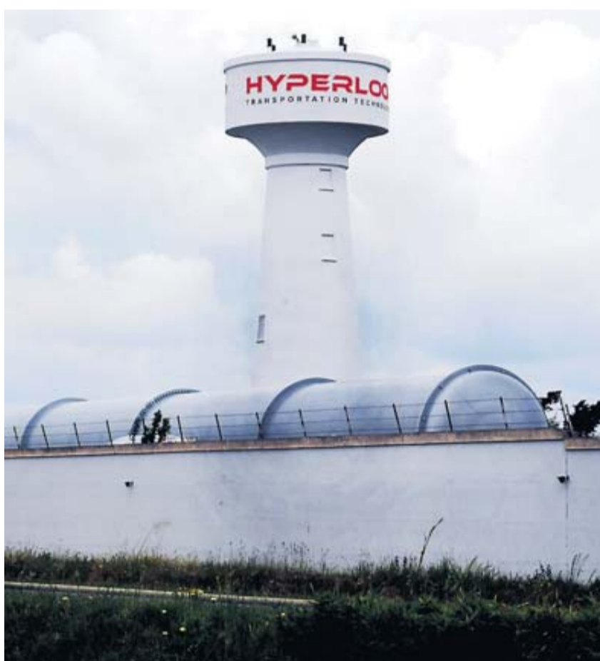
Hyperloop a aménagé dans la tour de contrôle. On peut voir les tubes d'essai. / DDM, NSA
