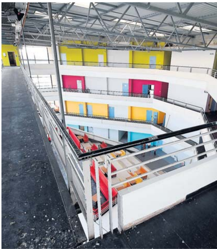
Cet été, la faculté a été remise à neuf après d'importants travaux. / DDM, Michel Viala
