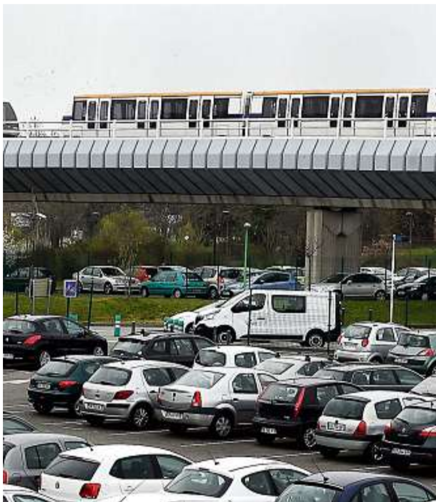
D'importants travaux vont être réalisés sur la ligne A fermée un mois. / DDM, archives
