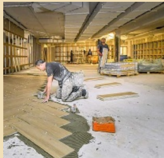
L'heure est aux aménagements intérieurs chez Basic Fit et H&M, qui doit ouvrir ses portes en novembre. Aurélien Laudy
