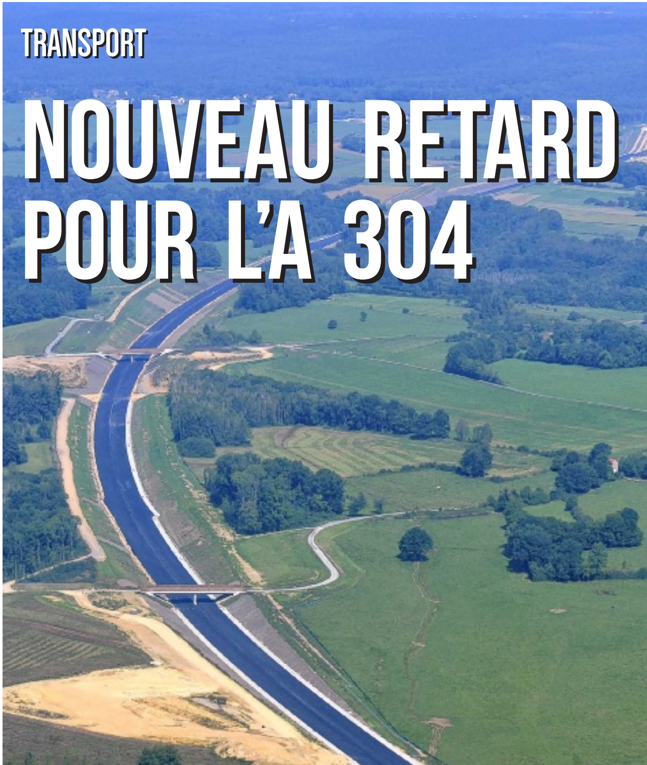
Des travaux complémentaires sont nécessaires pour stabiliser les sols des talus. Archives Karen Kubena
