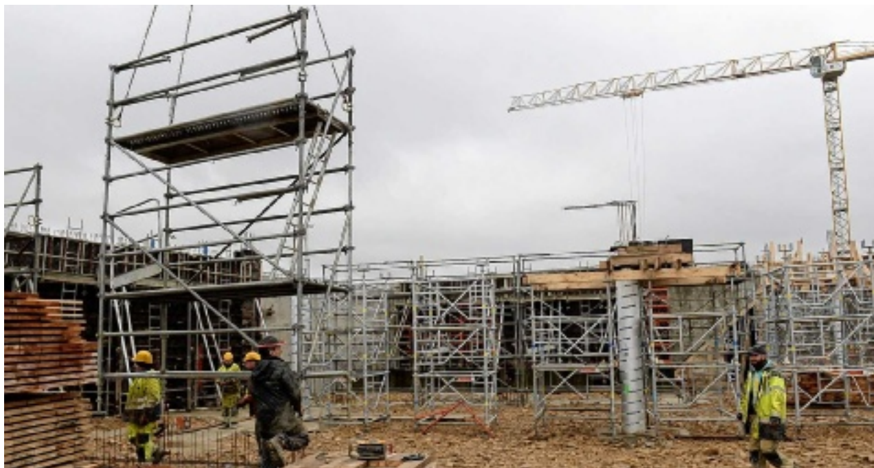
Sur le chantier, une trentaine d'ouvriers s'activent en simultané. Karen Kubena
